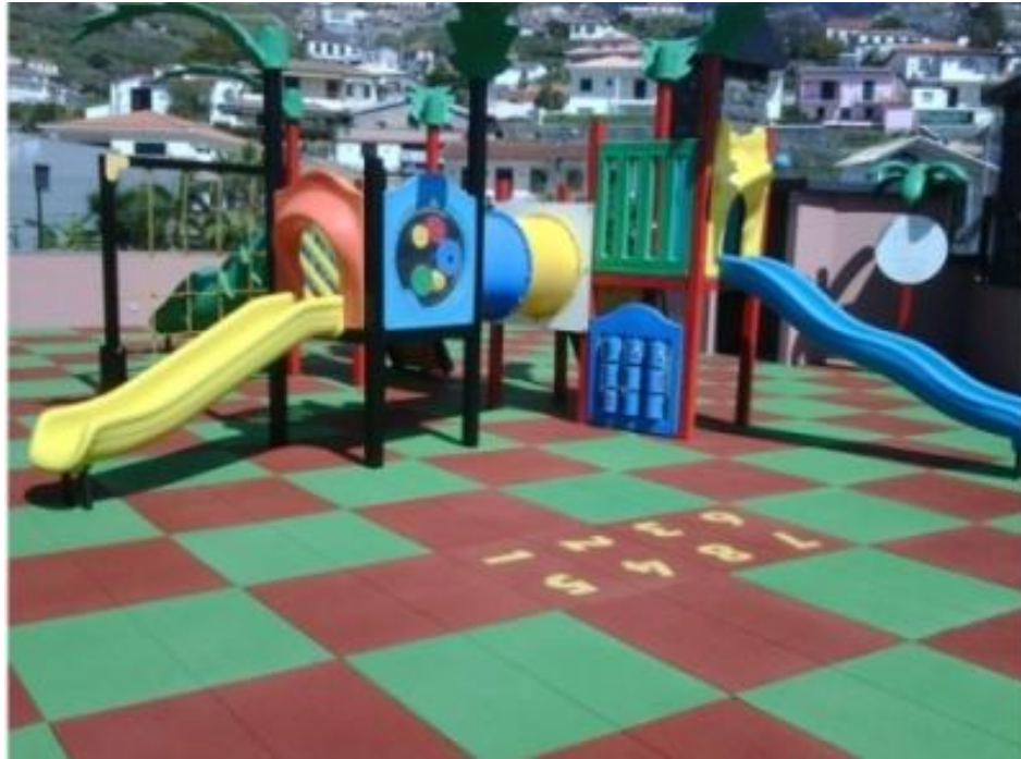
Fig. 19 – Pavimento de segurança
