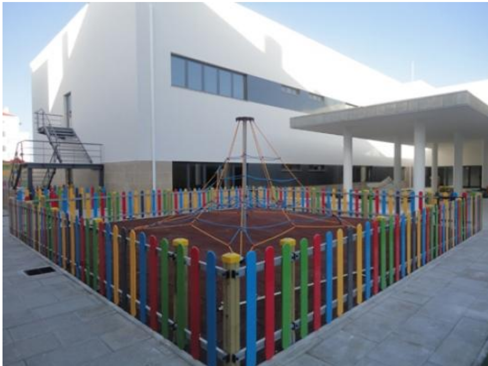
Fig. 20 – Vedação em polietileno
